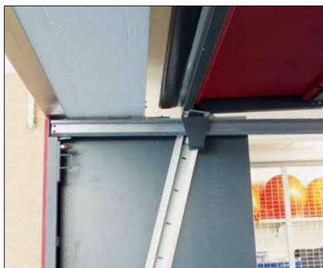
Pour les ouvertures de portes de moins de 231 cm, il est recommandé d'utiliser des ferrures spéciales. La hauteur de passage correspond à la hauteur de l'ouverture.
