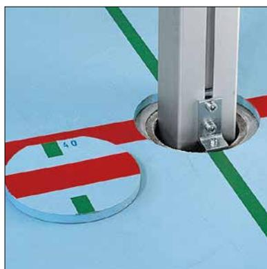
Les douilles ne doivent être scellées qu'avec du mortier coulé sans retrait. Livraison des couvercles pour les douilles par le fournisseur du revêtement de sol.
