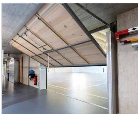
Porte basculante de local des engins avec verrouillage à 2 points et pêne de verrouillage à ressorts.
